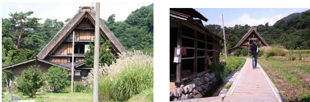
図4 東側からみた和田家（左 撮影記録／右 撮影状況の記録 ※GPS 位置情報とともに記録）
